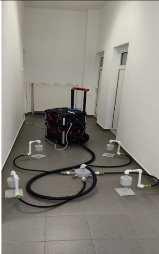
Exemplu de instalare a unui element aferent instalatiei pilot 1
